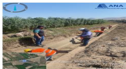
EJECUCION DE LAS ACTIVIDADES DE MANTENIMIENTO DE INFRAESTRUCTURA DE RIEGO DEL NUCLEO EJECUTOR NEPEÑA
